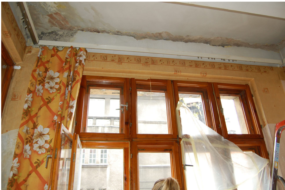
ODKRYWKA 3 – MIESZKANIE NR 3 – ZAWILGOCENIE NAROŻNIKA
